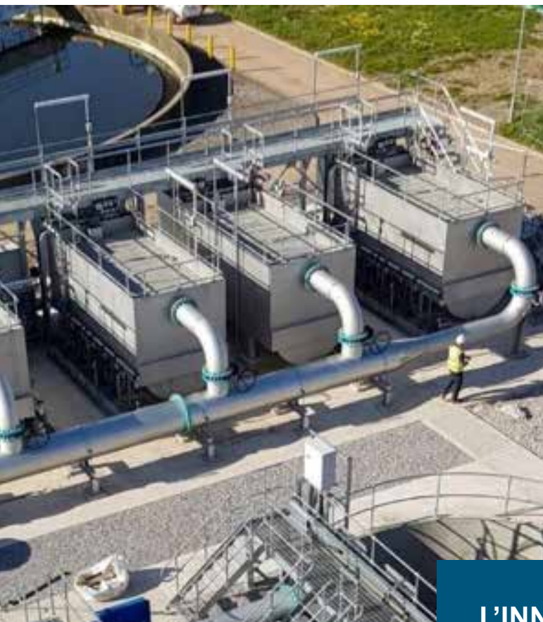
Crewe, Cheshire (Inghilterra)
