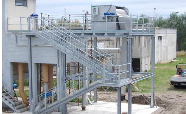
La rotazione del filtro è assicurata da un motoriduttore ortogonale di primaria marca come NORD o similari. All'interno del filtro è alloggiato un sistema di lavaggio dotato di ugelli da alimentare con acqua ad alta pressione mediante il quale si può provvedere periodicamente alla pulizia del tamburo filtrante.
