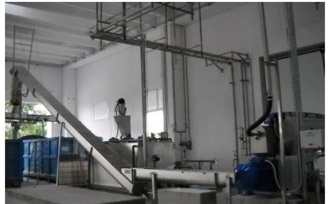
La canale è del tipo ad U con particolare profilo pressopiegato, rivestito internamente con materiale antiusura in materiale plastico ad alta densità molecolare, i coperchi superiori sono bullonati, la bocca di carico e scarico da definire in fase d'ordine a seconda delle esigenze del cliente. Le personalizzazioni portano anche al montaggio di gruppi di compattazione del grigliato con drenaggio della parte liquida e anche a particolari gruppi di tenuta con inseriti gruppi di controllo coppia.
