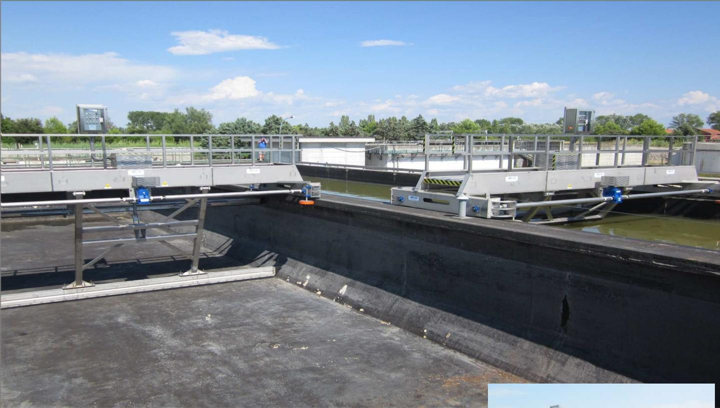
La dissabbiatura delle acque reflue è uno dei trattamenti meccanici preliminari a cui vengono sottoposte le acque di scarico all'ingresso degli impianti di depurazione per rimuovere e ridurre i materiali sospesi e galleggianti. In alcuni casi particolari, come per le acque di pioggia o lo scarico a mare, tali trattamenti non hanno carattere preliminare, ma possono costituire l'unico intervento prima della dispersione dei reflui nell'ambiente.
