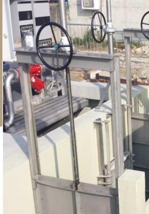
THREE SIDES SLUICE GATE
