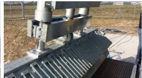
Lo sgrigliatore è dotato di dispositivo di sicurezza contro il sovraccarico tale che, se il pettine incontra un ostacolo superiore alla taratura, la macchina si arresta senza pericolo che qualche organo ne soffra e contemporaneamente una segnalazione luminosa indica il fuori servizio.
