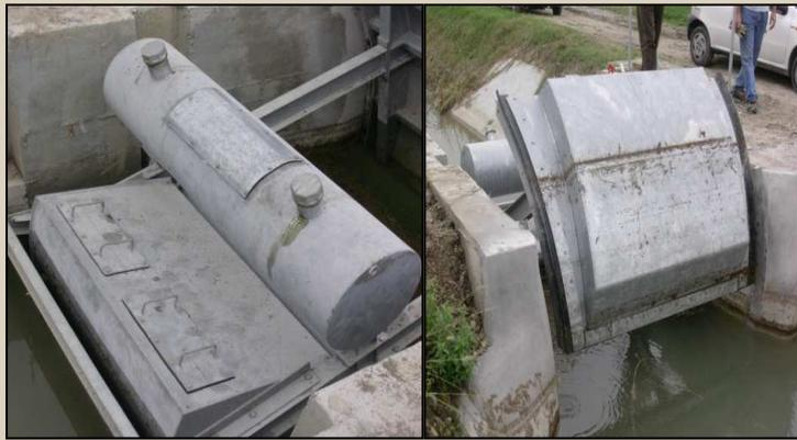
La paratoia autolivellante con autoregolazione del livello di monte o di valle è appositamente studiata per mantenere costante il livello del canale prima o dopo la macchina in modo da evitare piene o tracimazioni in canale.
