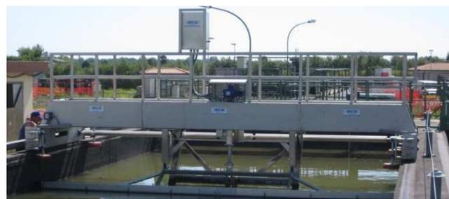
Il ponte "va e vieni" dissabbiatore - disoleatore è stato studiato e progettato per trattare e gestire materiali solidi, di densità molto superiore a quella dell'acqua e delle sostanze organiche putrescibili.
