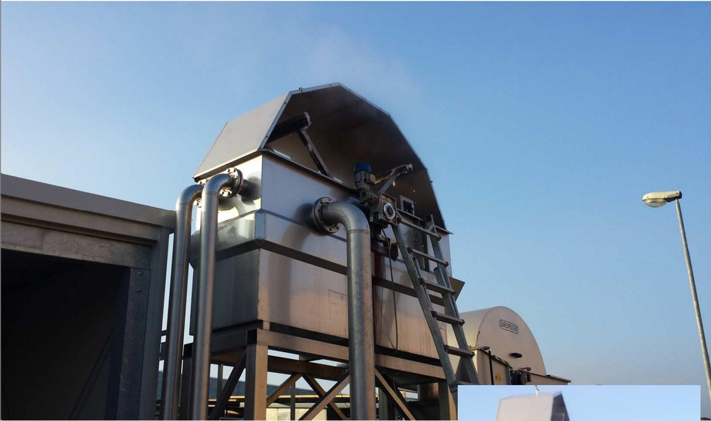
La macchina è appositamente studiata per la separazione di corpi solidi grossolani come stracci, pezzi di legno, frammenti di piante, carta, ecc. di effluenti civili ed industriali in canale appositamente studiato per gli impianti di depurazione, macelli, lavanderie etc.
