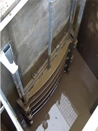
FOUR SIDES SLUICE GATE
