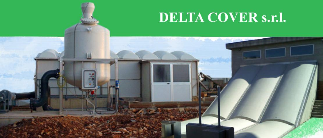
**Le coperture in PRFV rispetto ad altri materiali presentano i seguenti vantaggi:** leggerezza, elasticità, resistenza allo sforzo, resistenza agli agenti atmosferici, altissima durata nel tempo, assenza di manutenzione, facilmente removibili per qualsiasi tipo di intervento, semplicità di montaggio, peditonabilità e progettazione del manufatto in funzione dell'impianto.
